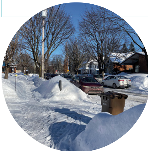
Trottoirs avec banquette végétalisée à Salaberry-de-Valleyfield (rue Montcalm).
